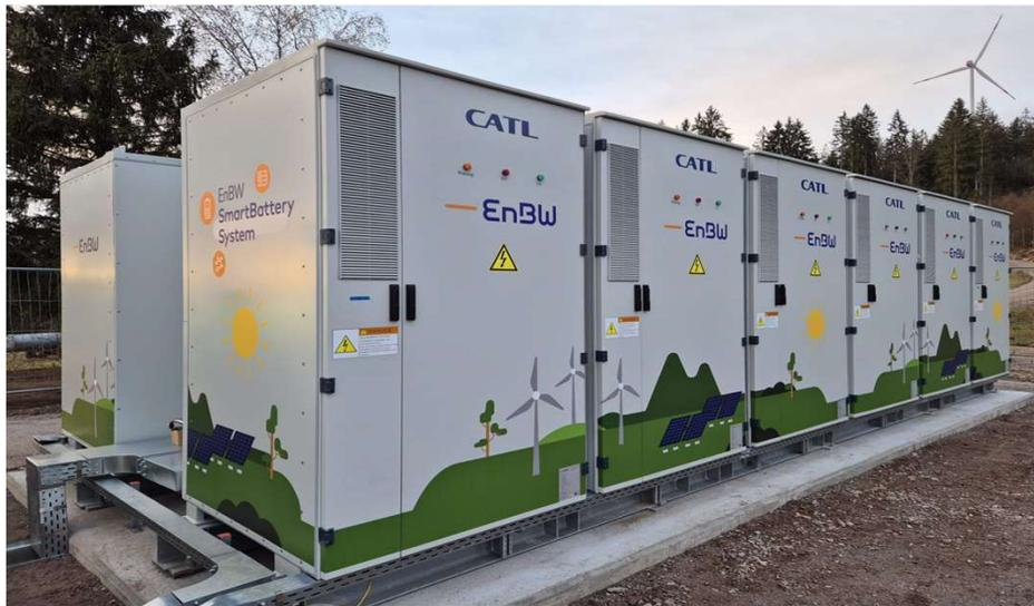
12 Batterie-Cubes (CATL) auf Streifenfundamenten mit einer Kapazität von je 372 kWh
